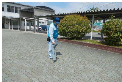
配管経路調査
