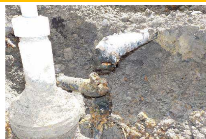
配管の破損
